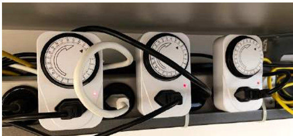
Aus Energiespargründen sehr zweckmässig: Zeitschaltuhren
