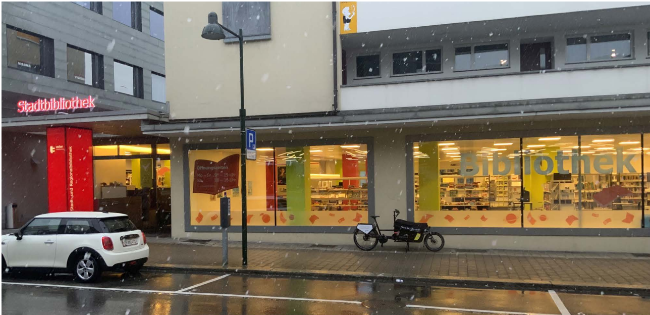
Abb. 2: Außenansicht des östlichen Teils der Stadt- und Regionalbibliothek Uster (Foto: Roman Weibel, Uster)
