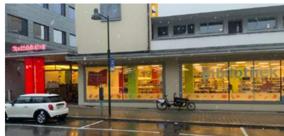
Aussenansicht des östlichen Teils der Stadt- und Regionalbibliothek Uster
